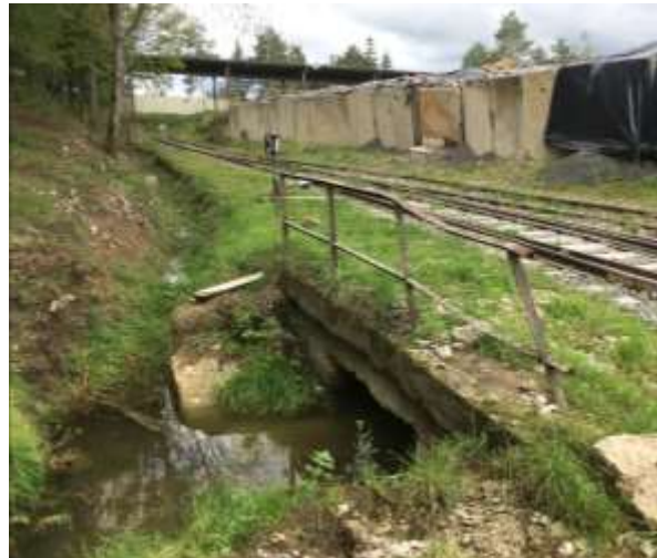
Odvodnenie železničnej vlečky je popod areál závodu odvádzané do recipientu
