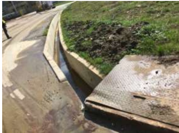
vody z povrchového odtoku sú zachytávané a rigolom odvádzané cez lapač RL do čističky vôd
