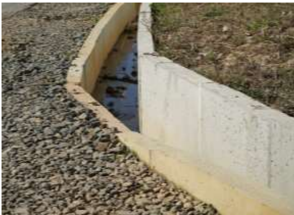
vody z povrchového odtoku sú zachytávané a rigolom odvádzané cez lapač RL do čističky vôd
